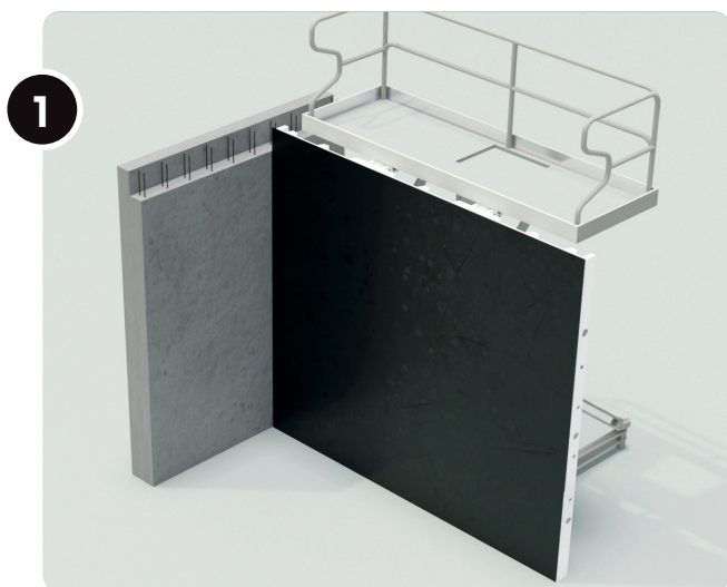
Pose de la première banche.
