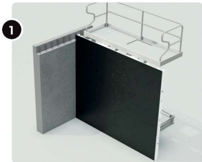
Pose de la première banche.
