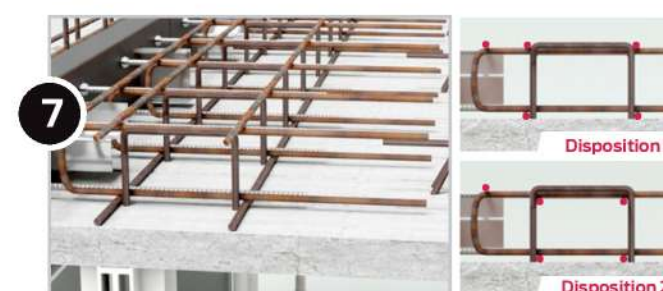
Installation du treillis de chapeau et fermeture de dalle selon BE.
